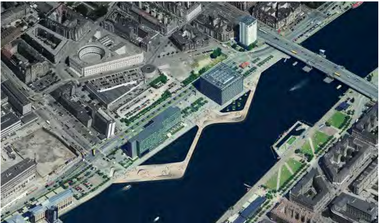
Das „Kalvebod Wave“, Kopenhagens zweites Hafenbad (Entwurf: The Danish Foundation for Culture and Sports Facilities)
