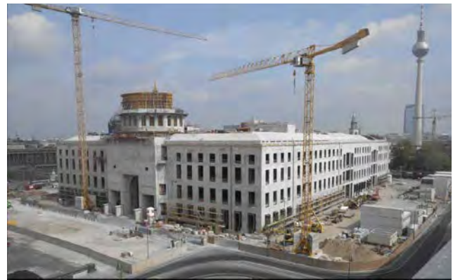
Bauarbeiten zum Berliner Schloss (Foto: Flussbad Berlin e.V.)
